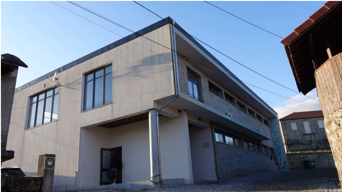
Figura 28 - Edifício "Padre Dr. Manuel Alves" - Sede da banda
