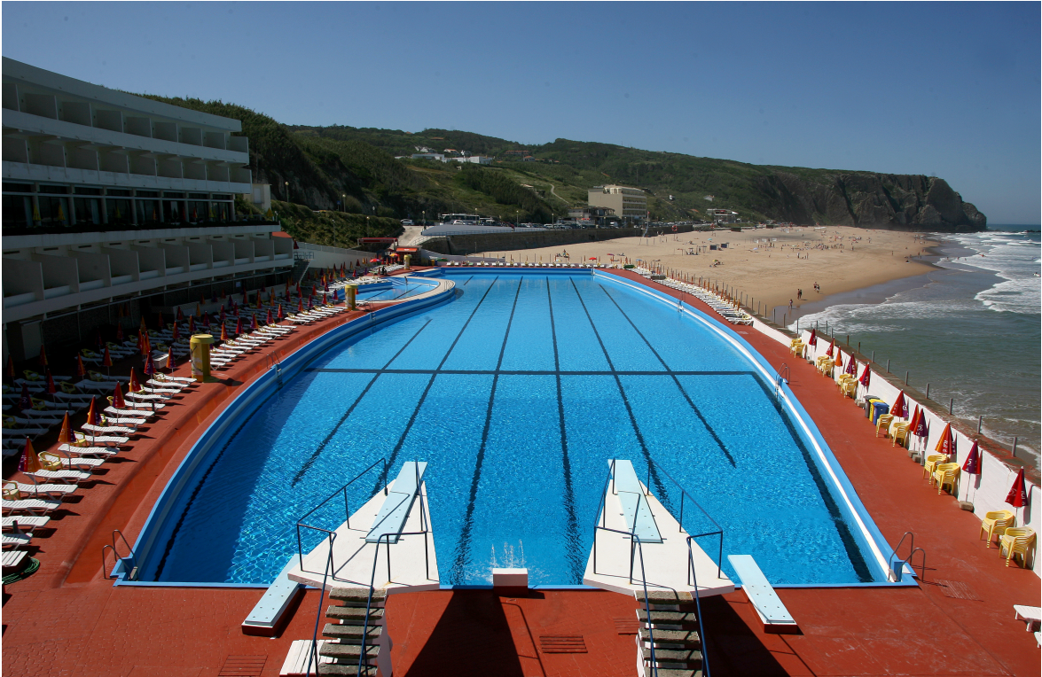
Figura 3.5 – Piscina exterior de água salgada do Hotel Arribas
