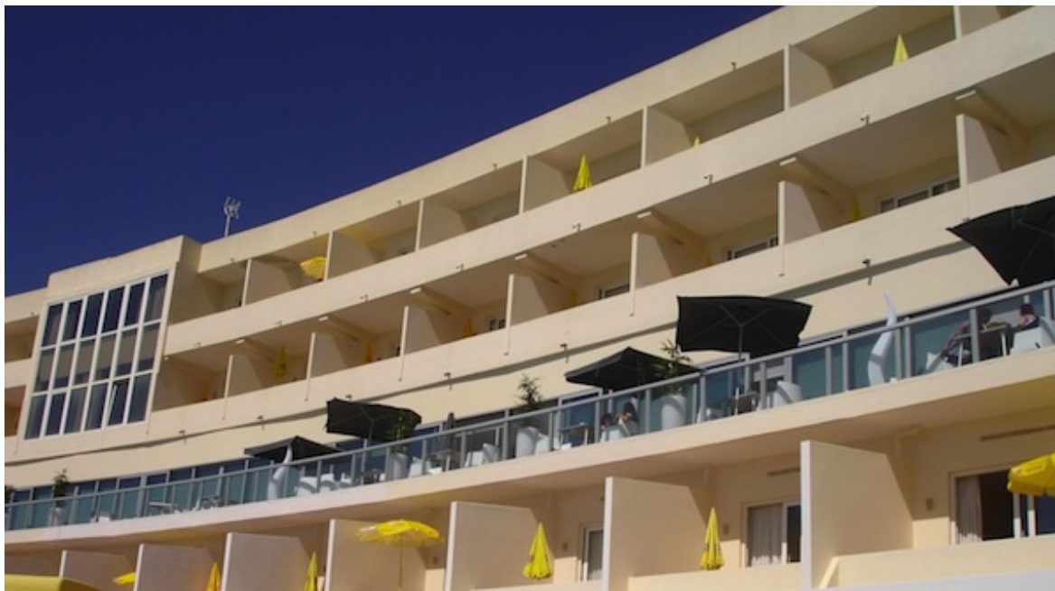
Figura 3.4 – Foto do terraço e esplanada exterior do hotel
