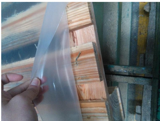
Figura 17: Falha de pregagem
