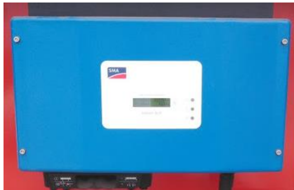
Figura 20. Inversor utilizado en la mini-central fotovoltaica.
