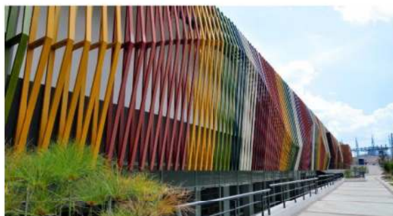
Figura 2.- Fachada lateral del Centro Comercial Quitus, entrada secundaria calle Versailles.
