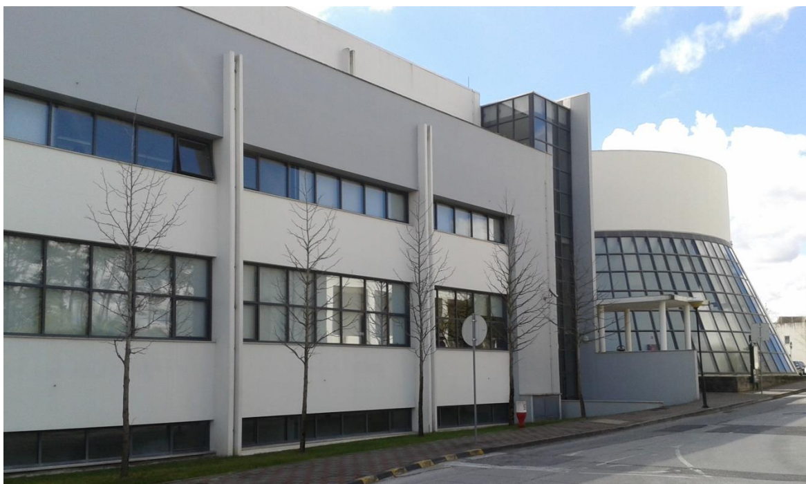
Figura 4.4 - Algumas características do Edifício D
