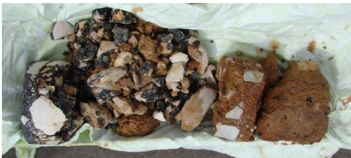
Quadro 2 – Inspeção Visual Carotagem 2 – C2
