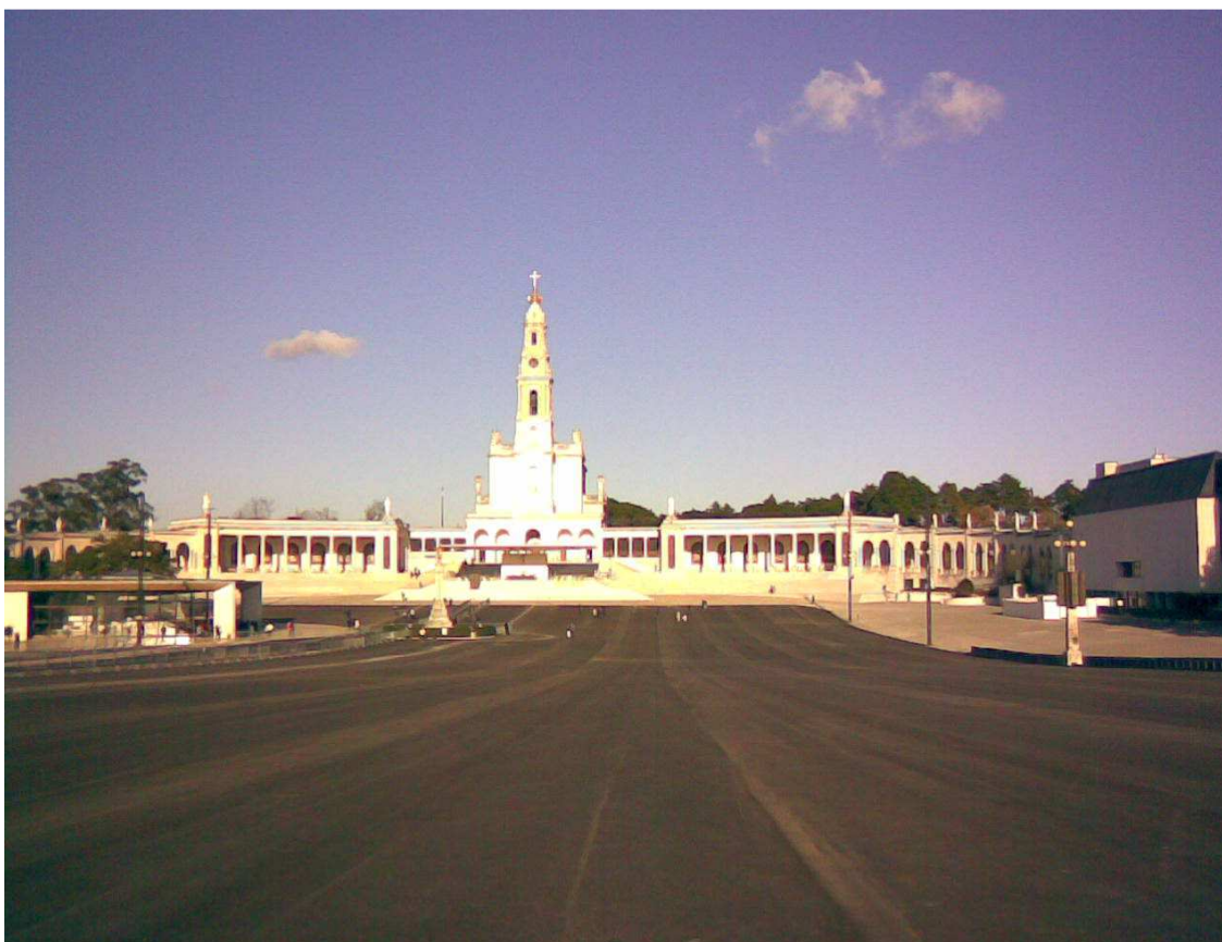
Figura 8 – Conclusão dos trabalhos de aplicação de mistura betuminosa colorida
