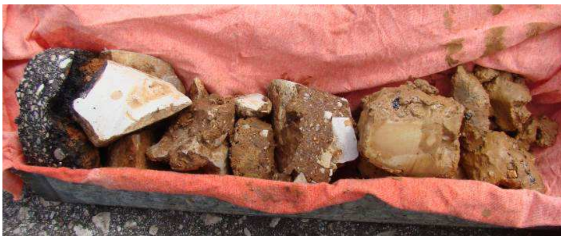
Quadro 3 – Inspeção Visual Carotagem 3 – C3
