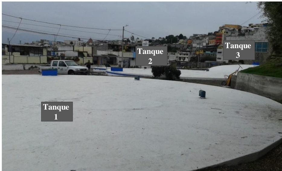
Figura 15. Tanques reservorios del sistema Troya
