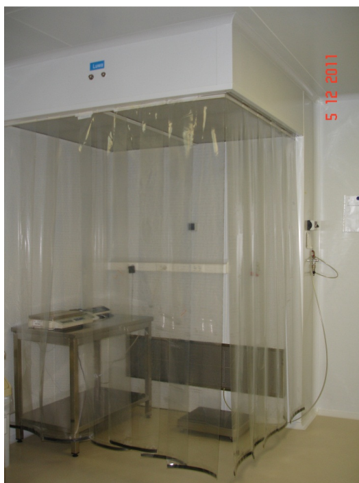
Figura 2.2- Câmara de pesagem do FSO1
