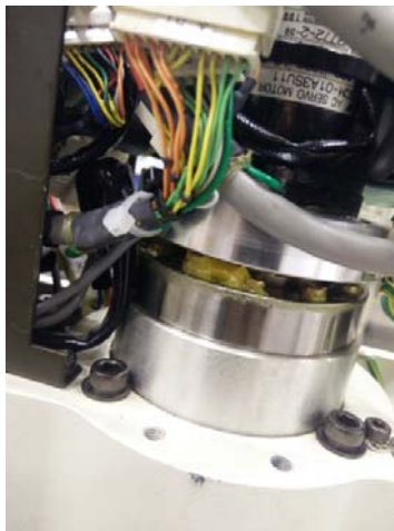
Figura 38 - Processo de remoção do motor do eixo 2.
