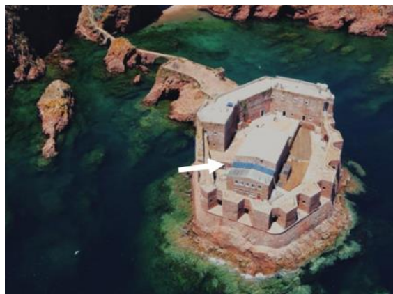
Figura 16: Forte de São João Baptista visto de cima, onde se consegue observar os painéis fotovoltaicos instalados no terraço pela AAB. Fonte: Facebook da AAB, 2022.Consultado em: https://www.facebook.com/aaberlenga/?locale=pt_PT
