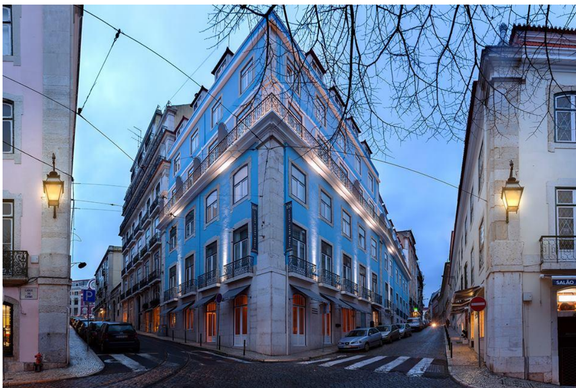
Figura 2. 1– Fachada do Lisboa Carmo Hotel
