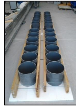
c) Colocação dos tubos \text{Ø}315 e da estrutura de aperto
