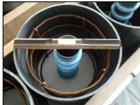
h) Colocação das armaduras de confinamento
