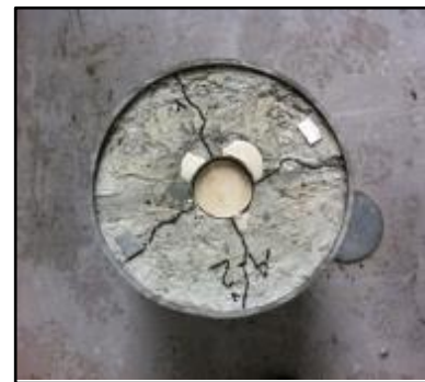
b) Fendilhação radial do betão envolvente observada no ensaio A-2
