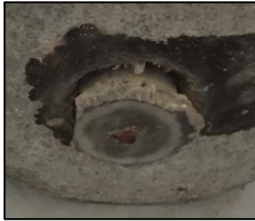
a) Rotura pela interface calda / betão observada no ensaio C6-1
