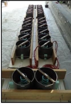
i) Colocação das armaduras de confinamento
