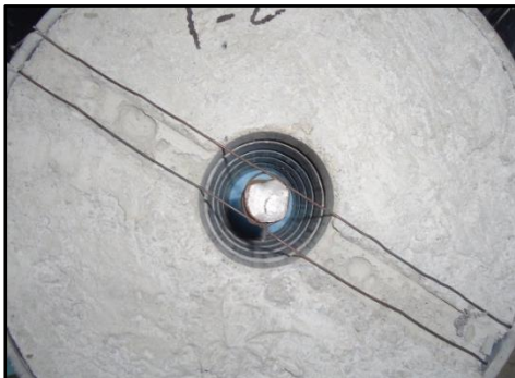
o) Sistema de amarração dos varões
