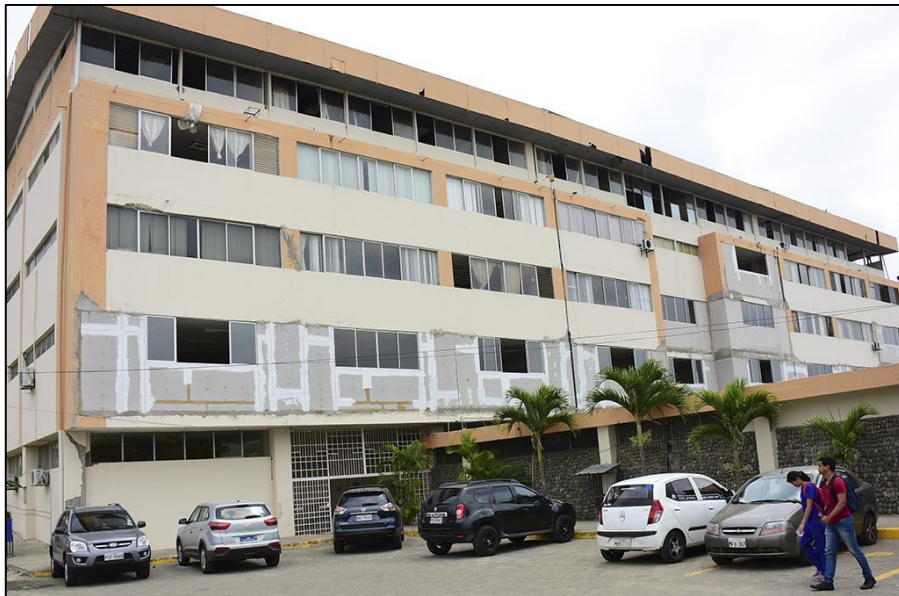
Ilustración 5.1.- Edificio FFLCE – UTM – Estado actual.
