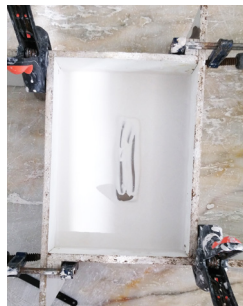
IMG.100 e 101/ Execução do molde em gesso
