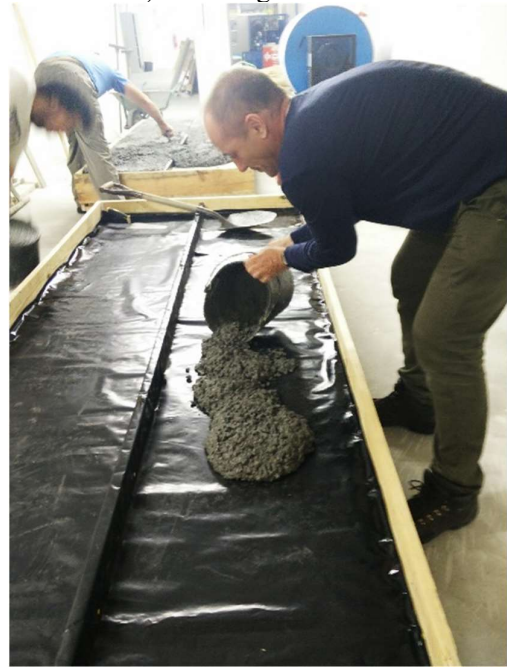
j) Betonagem das lajes com filme plástico
