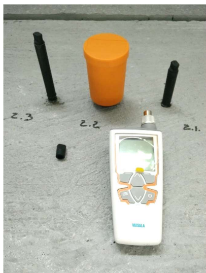
a) Período de estabilização dos valores de humidade e temperatura internas do betão no furo 2.2
