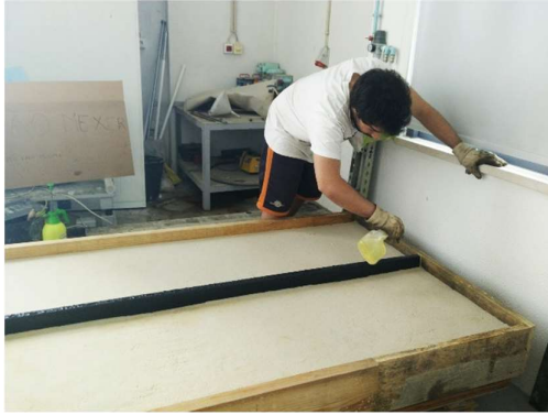
g) Colocação de descofrante nas lajes
