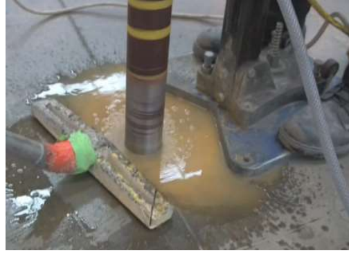
b) Carotagem do pavimento
