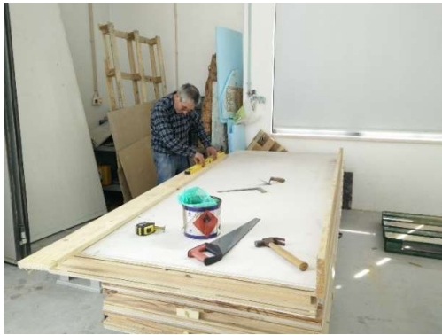
a) Bases da cofragem
