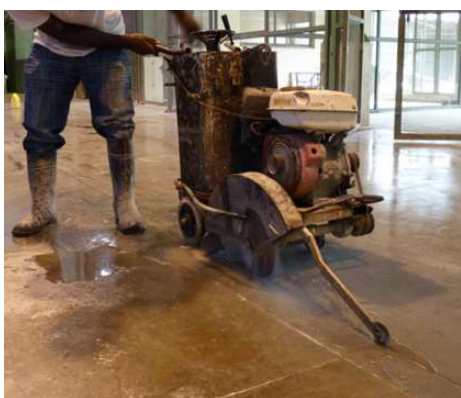
a) Execução de Junta Serrada no Pavimento (Retirado de: http://pisoconcreto.com/piso-concreto/piso-concreto-polido )
