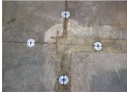
d) Reabilitação concluída
