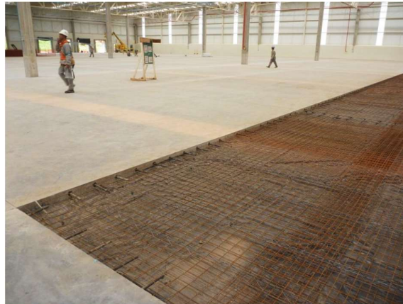
Figura 8 – Piso duplamente armado (Retirado de: http://www.rhinopisos.com.br/site/produtos/36/piso_industrial_pavimento_concreto )
