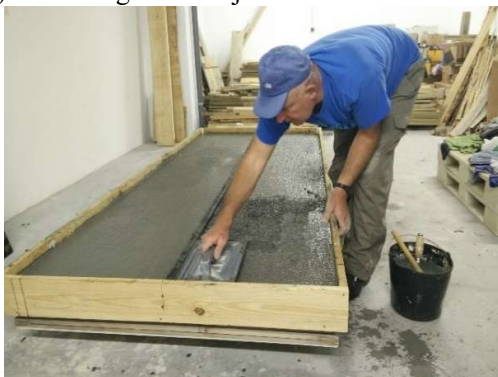
k) Acabamento das lajes com a talocha
