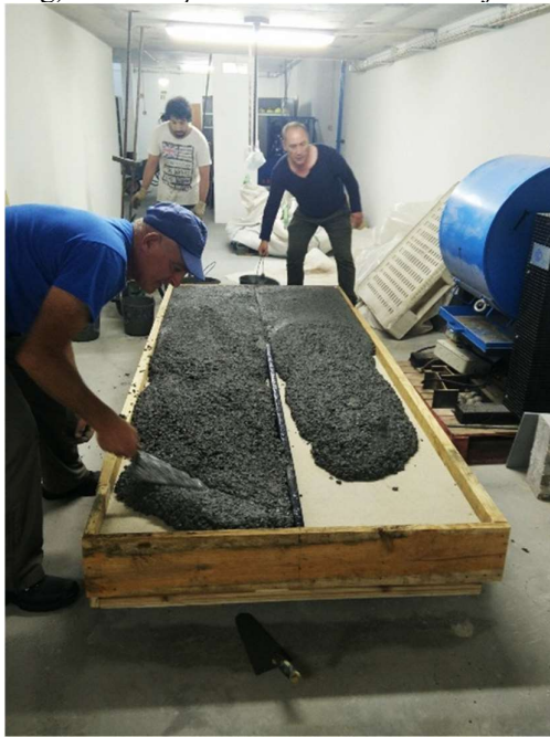
i) Betonagem das lajes com sub-base de areia
