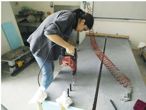
e) Furação da laje para a colocação dos tubos plásticos
