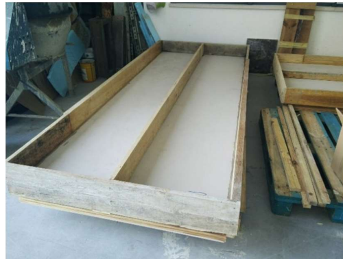
b) Cofragens realizadas
