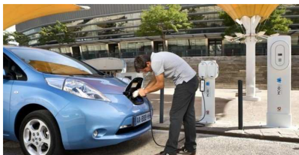
Figura 2.4 - Posto de carregamento de energia elétrica (Mobilidade Elétrica) [26].
