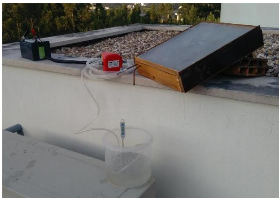
Figura 57 – Testes do painel solar AQS.
