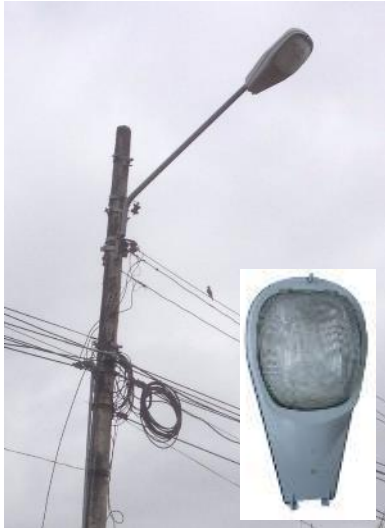
Figura 39-Luminaria de Vapor de sodio de alta presión (Elaboración propia)
