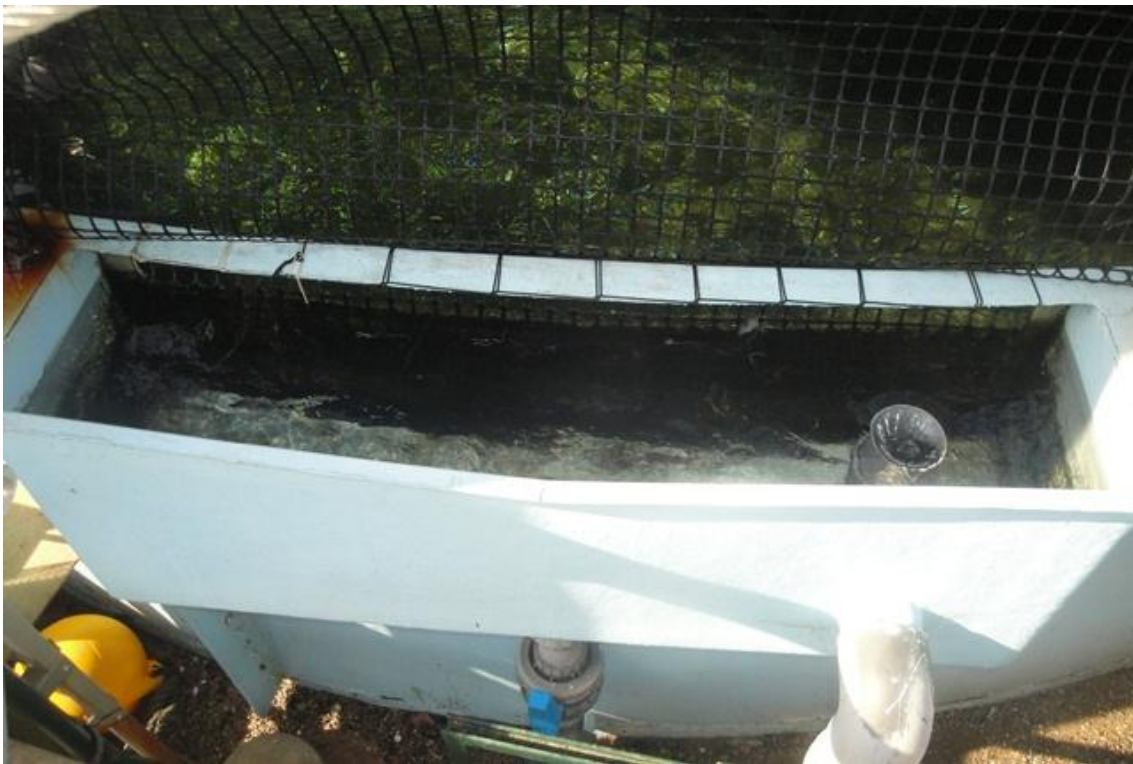
Figura 17. Skimmer Este do Tanque Central. À direita da imagem está o 'tubo ladrão' que esgota a água da superfície após enchimento do tanque. Quando atinge o nível do tubo, a água deixa de ser lançada para o esgoto e, com a circulação, a água superfície é deslocada para o skimmers , onde se vai acumular a matéria orgânica, antes na superfície.
