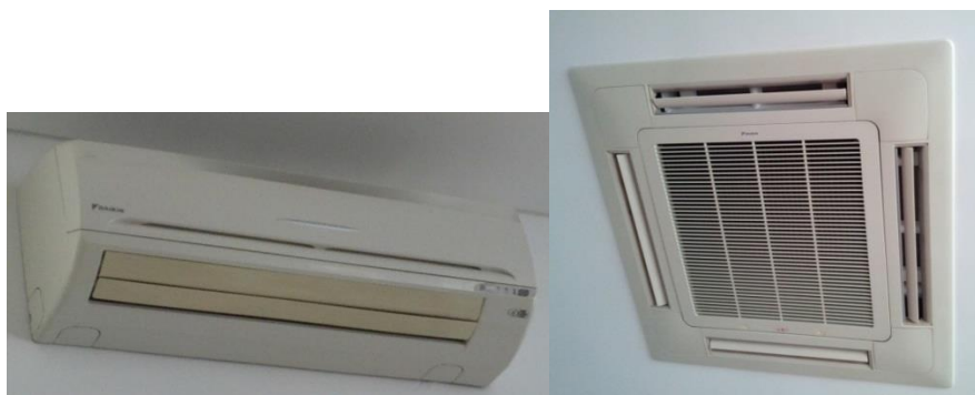
Figura 14-Bomba de calor do espaço administrativo e da recepção e do espaço multiusos, respectivamente
