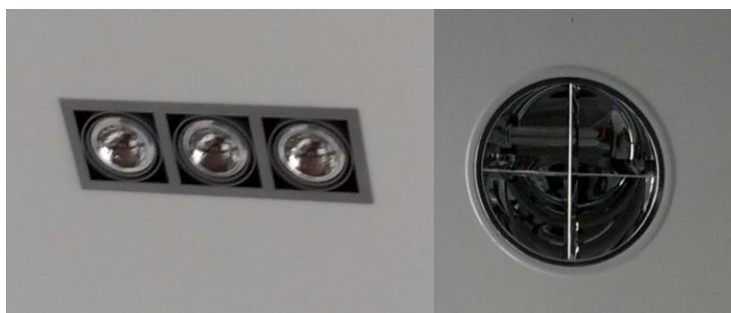
Figura 13-Focos de iluminação da sala multiusos e projectores do hall de entrada, respectivamente
