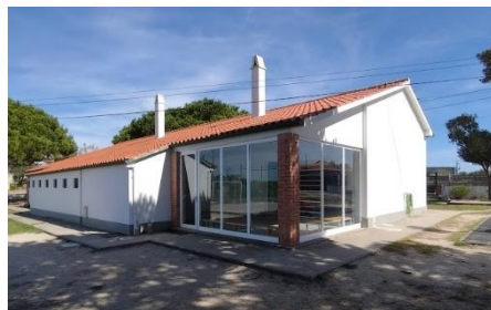
Figura 2- Vista sul da escola
