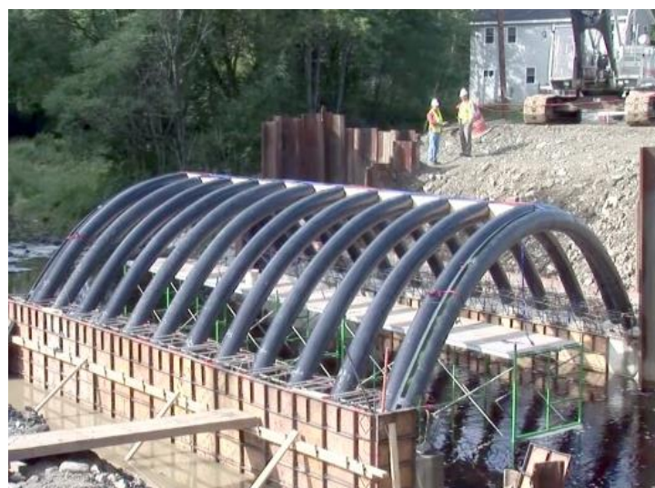
Figura 17 - Pontes de betão utilizando arcos em Polímeros Reforçados com Fibras de Carbono; https://www.engenhariacivil.com/construcao-pontes-polimeros-reforçados-fibras-carbono-cfrp (13/08/17)
