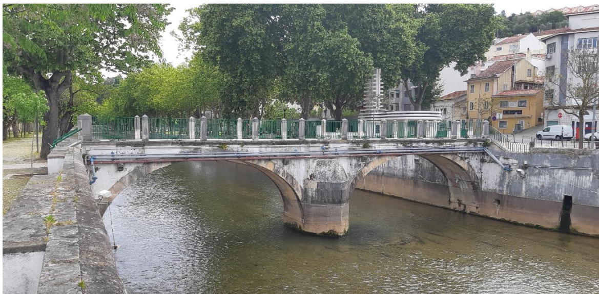
Figura 38. Ponte do Bairro dos Anjos
