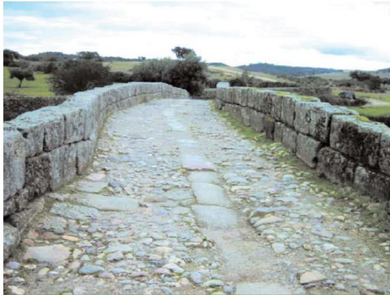
Figura 19. Ponte de Idanha-a-Velha - pavimento da ponte e muros de guarda (Reabilitação de Pontes de Alvenaria, 2002)
