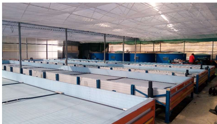
Figura 43 – Instalação realizada no espaço do cliente.
