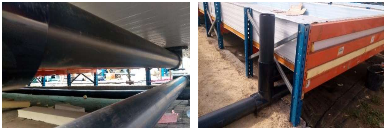
Figura 30 – Detalhes de canalização na zona inferior e lateral da cama de cultivo.
