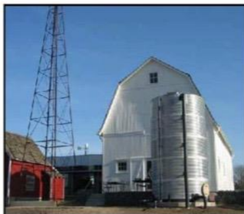
Figura 27 - Exemplo de uma cisterna
