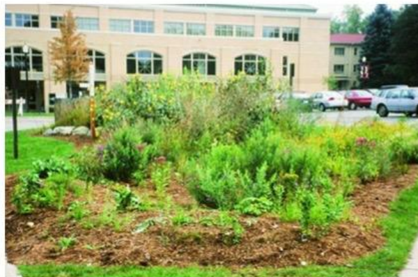
Figura 25 - Sistema de Bio-Retenção
