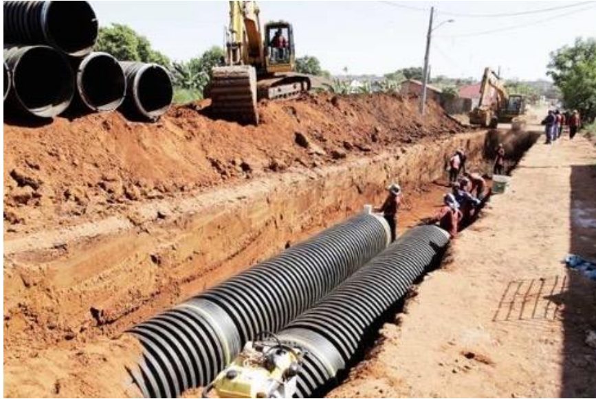
Figura 14 - Sistema de drenagem urbana
