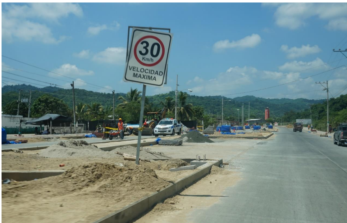
Figura 36. Parqueaderos en construcción en forma de batería, Parroquia de Leonidas Plaza. Foto autor
