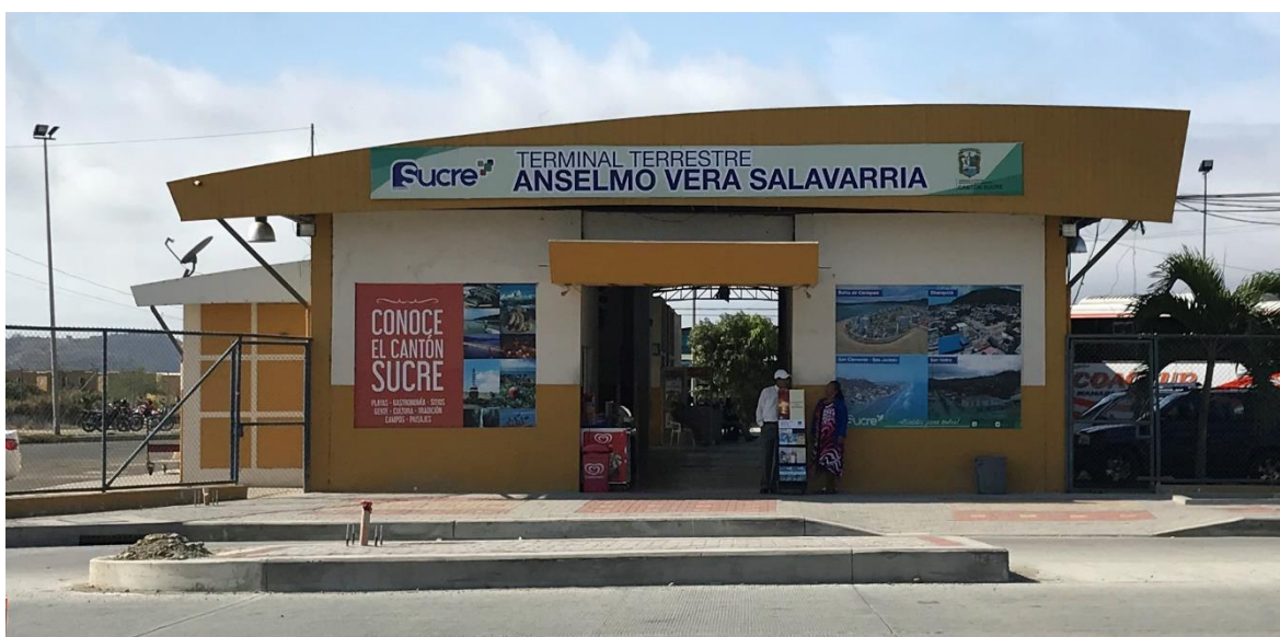
Figura 37. Terminal Terrestre Anselmo Vera Salavarría en Bahía de Caráquez. Foto autor
