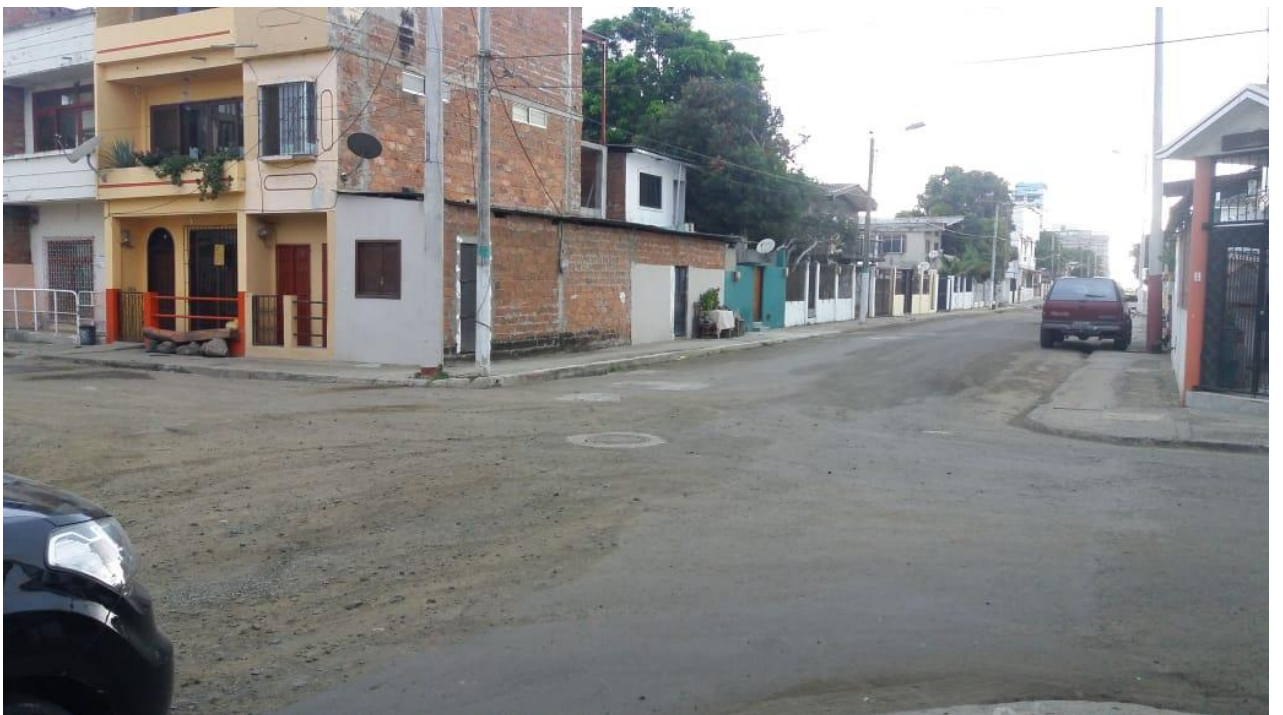
Figura 77. Estado de la calzada de la calle Muñoz Dávila. Foto autor
