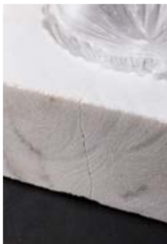
Figura 30. Fissura na pedra mármore
