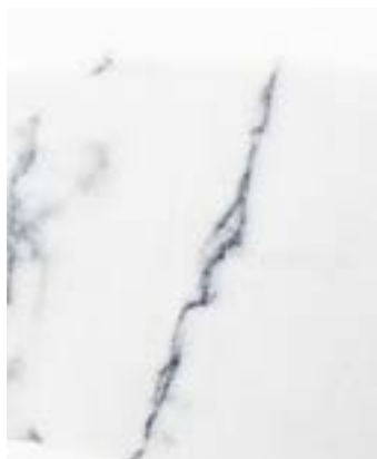
Figura 73. Pormenor do tampo rachado
