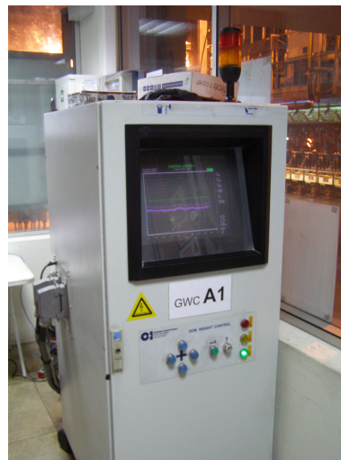
Figura 2.15: Fotografia do sistema de medição do peso da gota de vidro na BA Vidro, SA.
