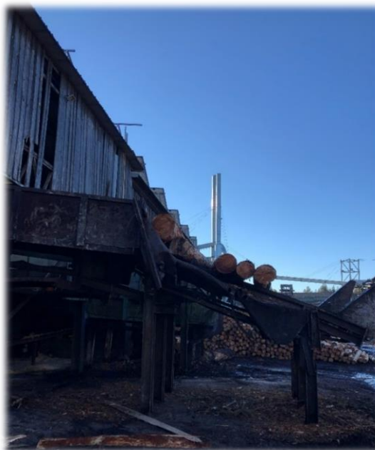
Figura 12 - Transportador de abastecimento da linha
