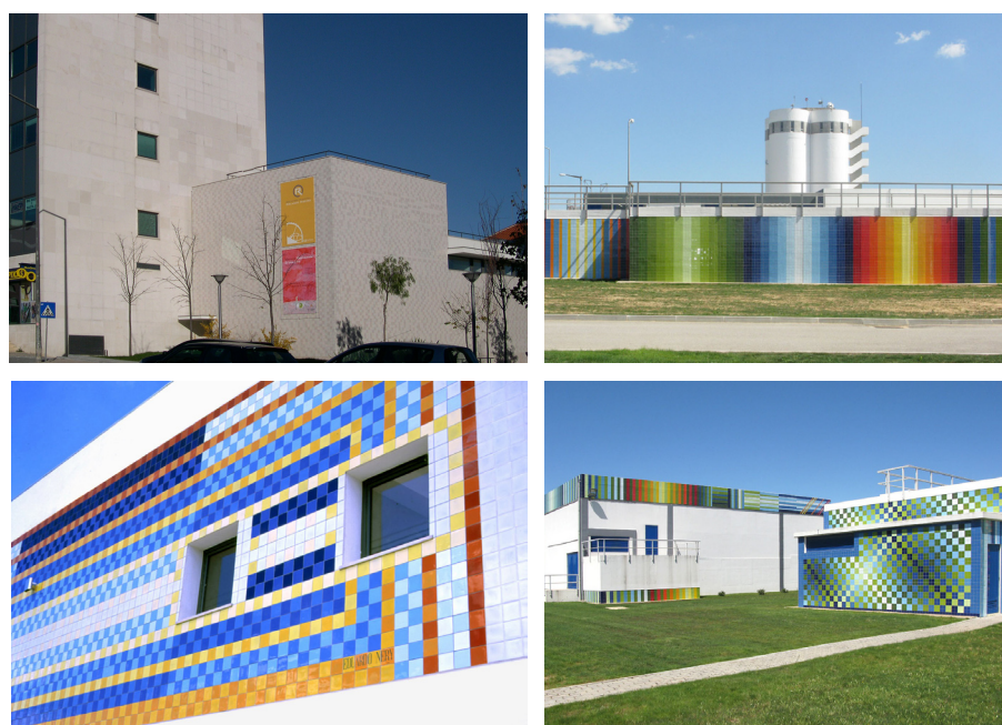
Fig.85 Condicionar, a percepção do edificado, através do padrão, sublinhando volumes, acentuando ou nivelando diferenças. Fotos: da autora e de Eduardo Nery.
