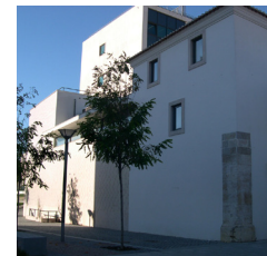
Fig. 1 Articulação entre edifícios de épocas distintas. Foto da autora.
