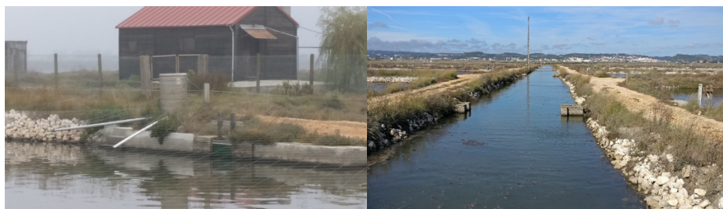
Fig. 2. a) Zona de saída de água dos tanques com a presença de alimentadores, rede de protecção contra aves, grades de rede e porta de madeira. b) Vala e greiros Piscicultura do Torrão e Vale da Vinha.
