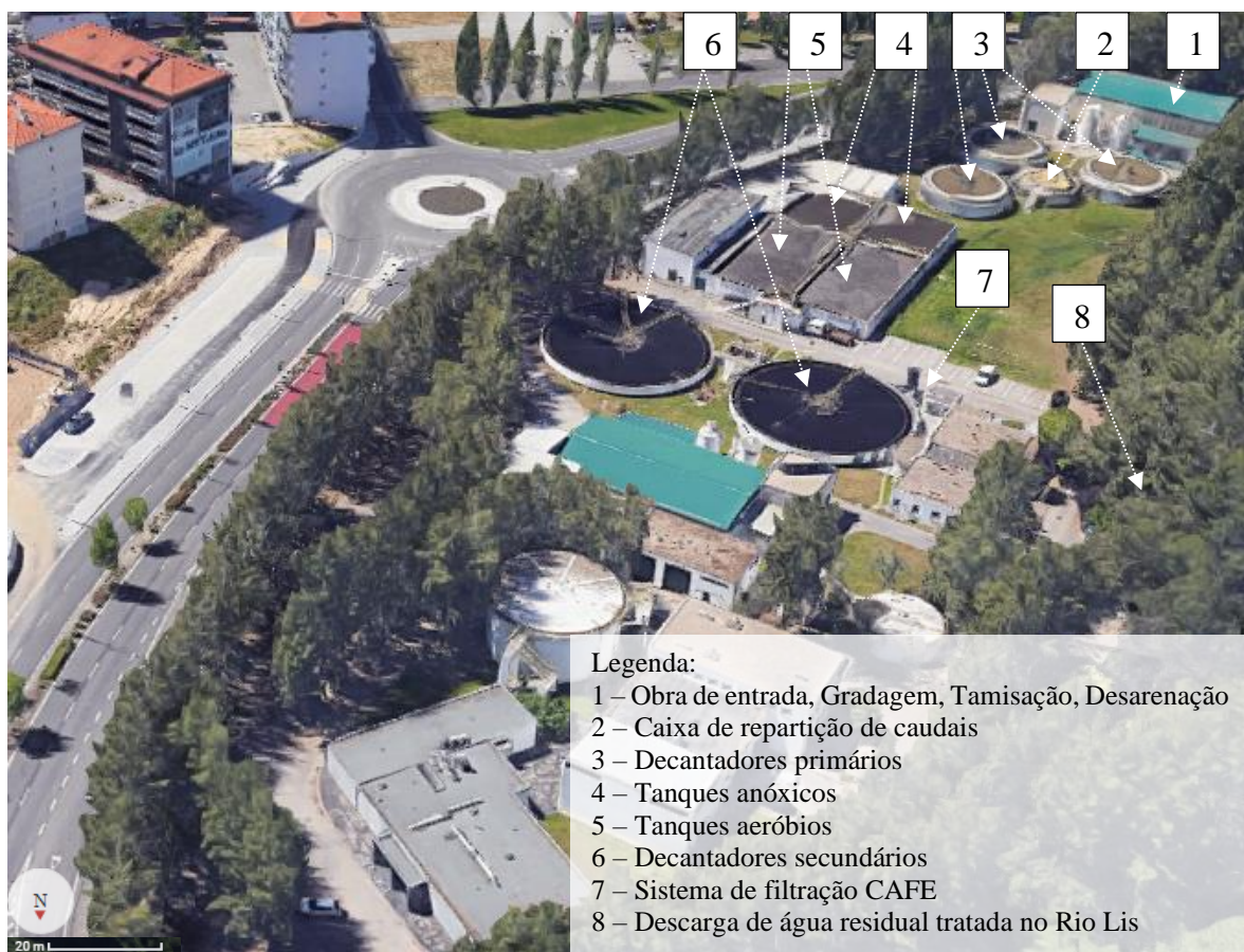
Figura 2.1 – Vista da ETAR das Olhalvas, com a indicação dos processos do tratamento da fase líquida (legenda do autor sobre vista 3D da ETAR de Olhalvas - Google Maps, 2023)
