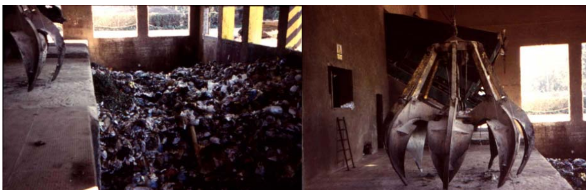
Figura 3.6 – Vistas da Fossa da Instalação da LIPOR
