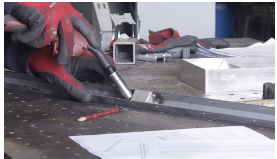
fig.173- Soldadura do elemento de estruturação no perfil
