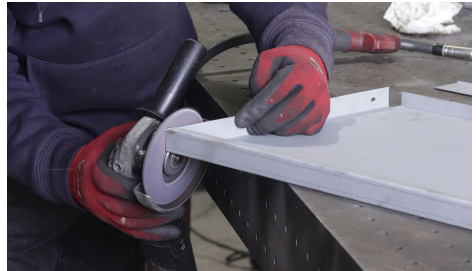
fig.176- Retificação da soldadura na base do armário
