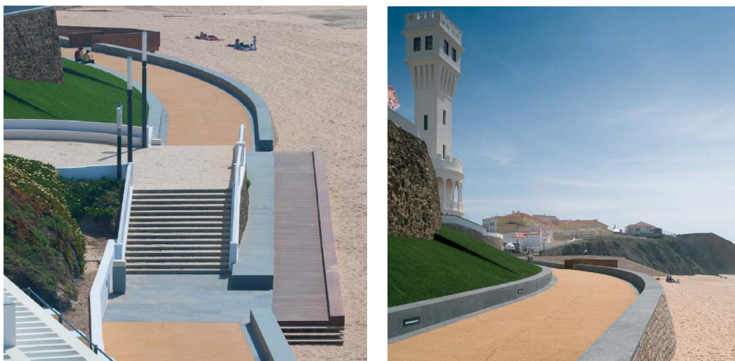
Figura 5.3. Requalificação da zona pedonal que liga a praia da Azenha à praia do Centro.
