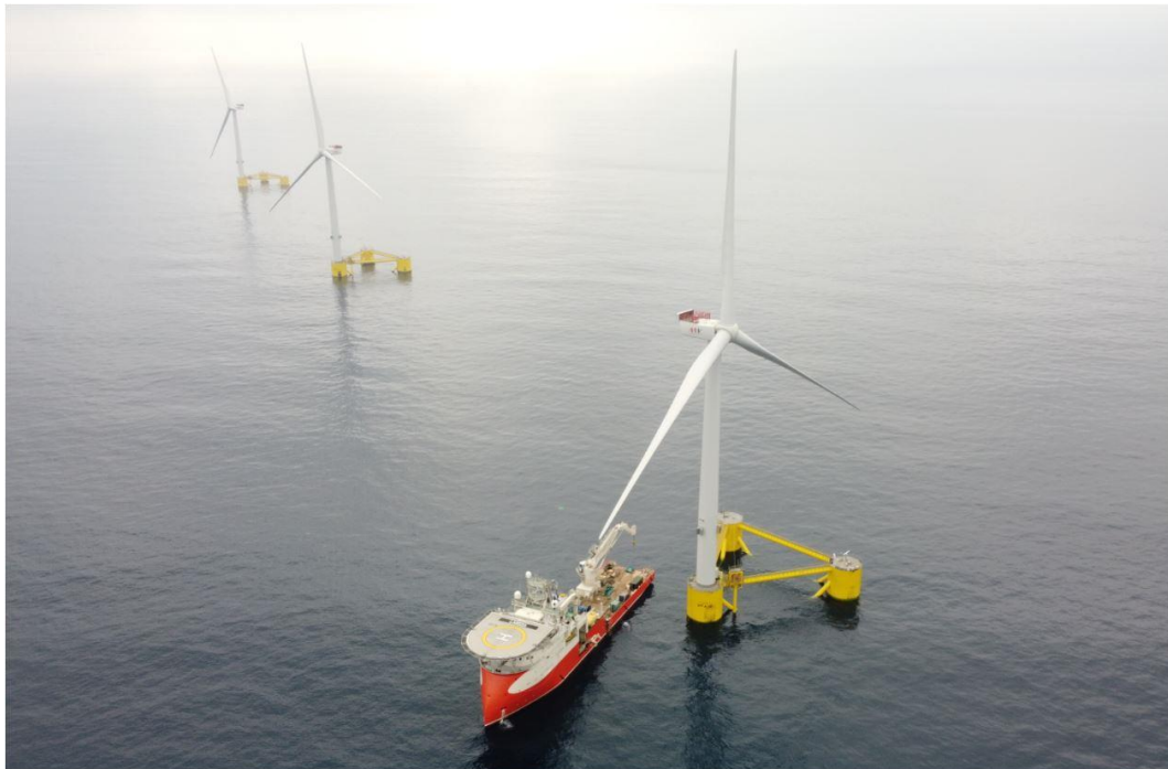
Figura 7 - Fotografia do parque eólico WindFloat Atlantic . Fonte: EDP 8
