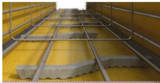
Figura 9 - Aplicação de Espaçadores de Betão [23]
