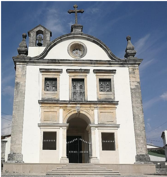
Figura 31 - Capela Santa Marta | Fonte: Própria
