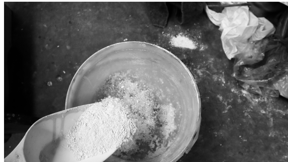
FIGURA 32: Preparação do gesso.
