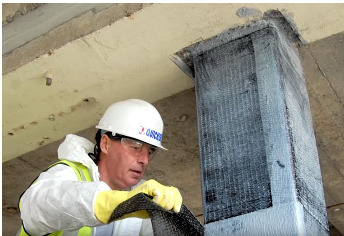
Figura 43 - Aplicação de reforço com fibras de carbono, SikaWrap® (adaptado Sika)
