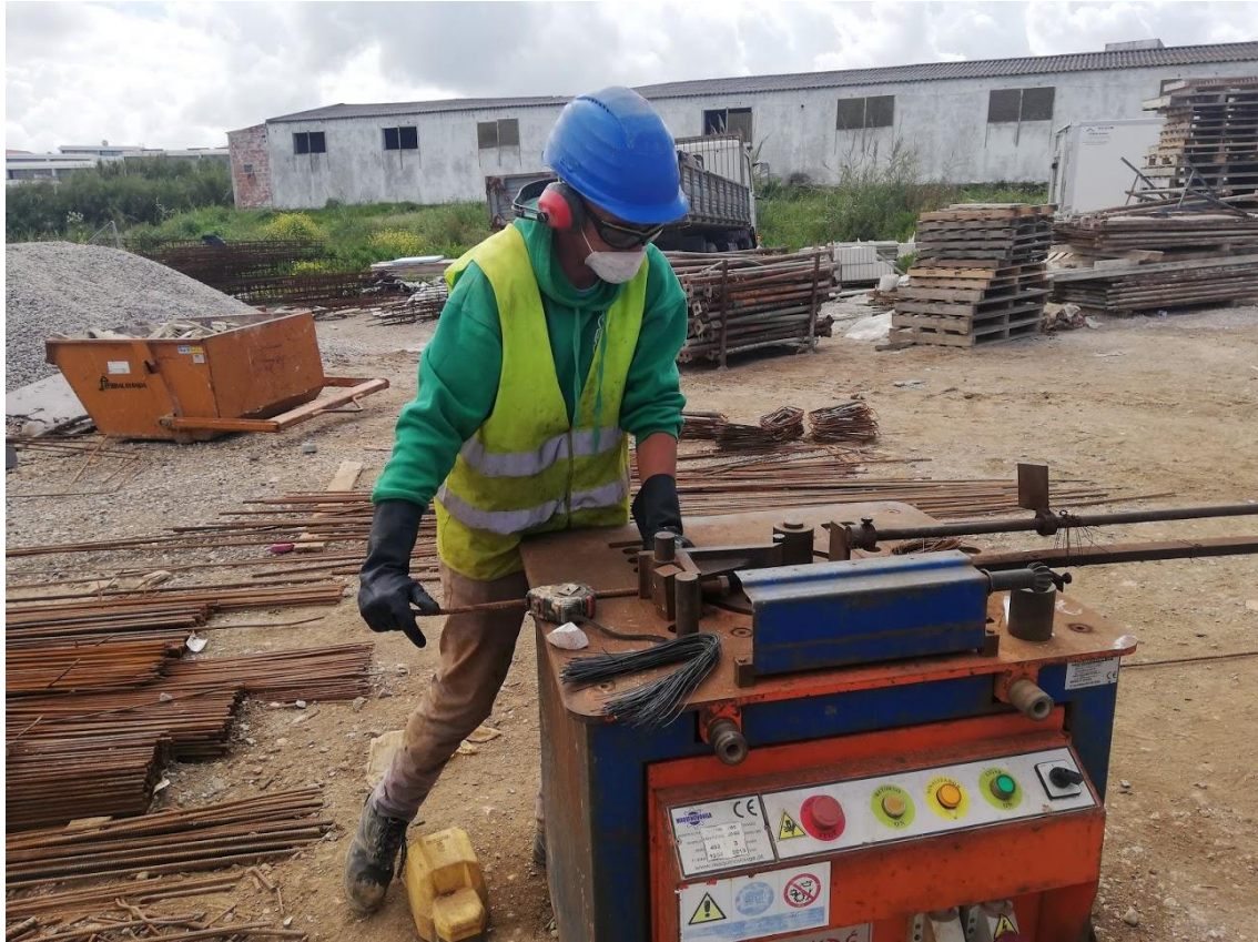
Figura 50 – Fotografia de trabalhador com os EPI, incluindo máscara para vias respiratórias
