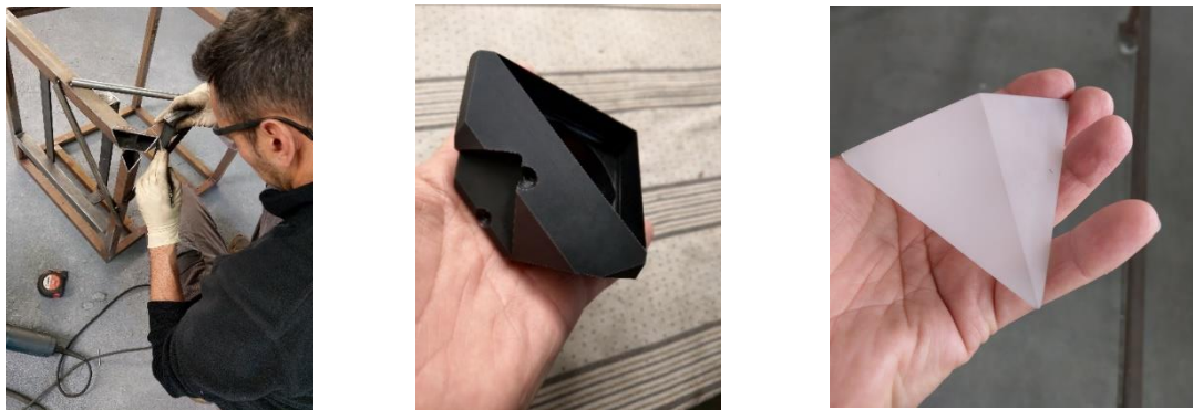
Figura 34 - Detalhe de instalação da ótica de sinalização sinalizadora
