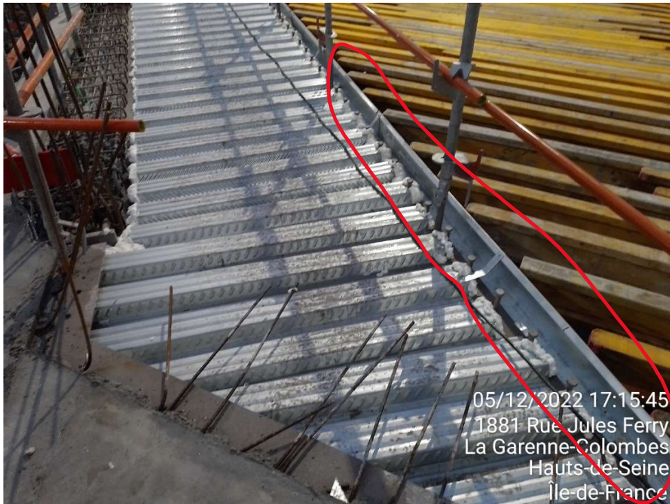
Figura 48 – Remate de bordadura (Fonte: Autor)
