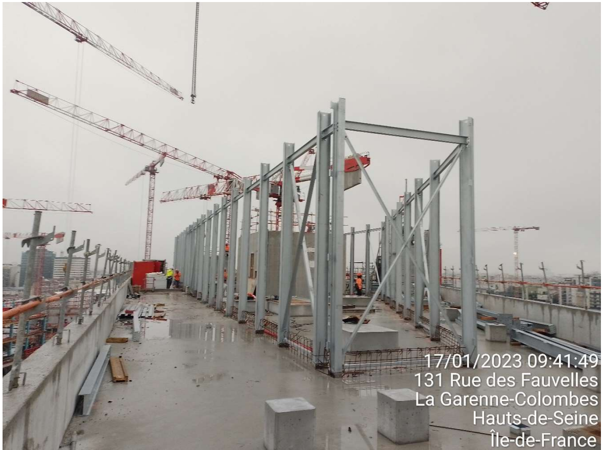
Figura 52 – Casa de máquinas montada (Fonte: Autor)
