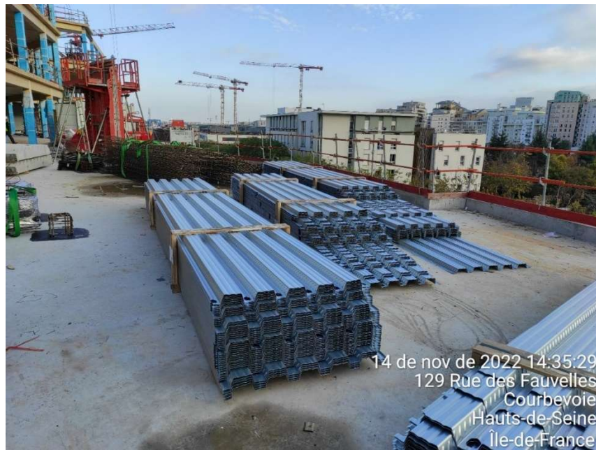
Figura 44 - Chapa colaborante (Fonte: Autor)
