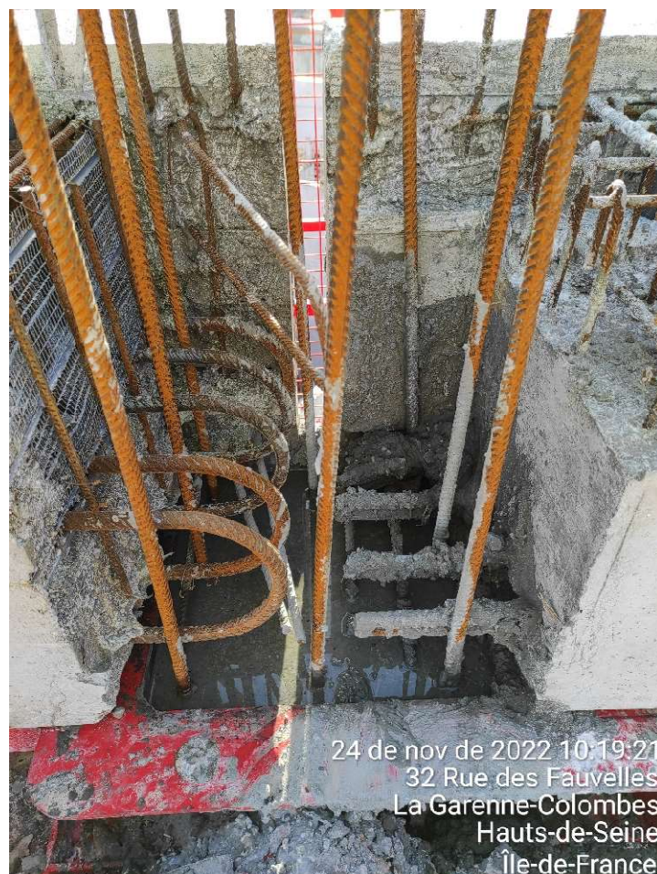
Figura 28 - Pilar de recebimento do chumbador (Fonte: Autor)
