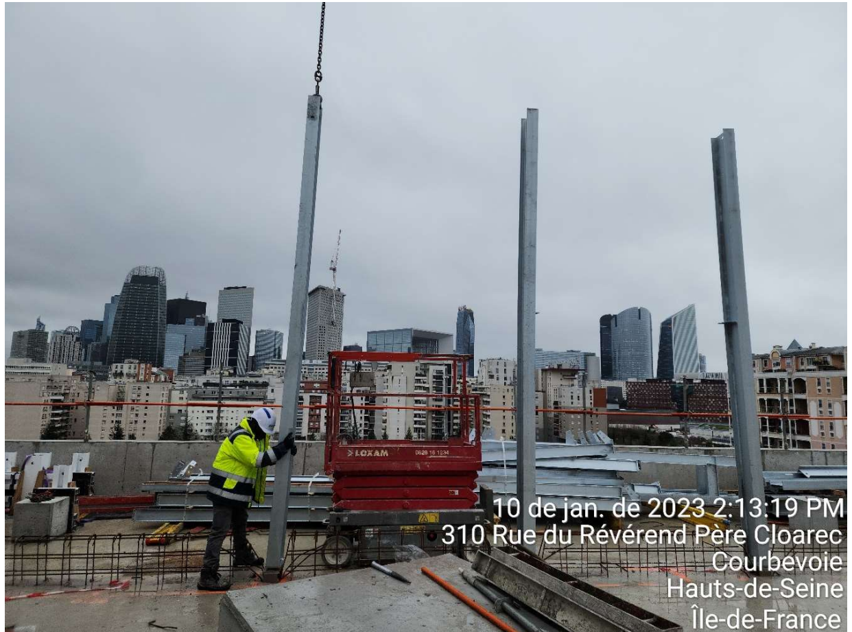
Figura 51 - Montagem dos pilares da casa de máquinas (Fonte: Autor)
