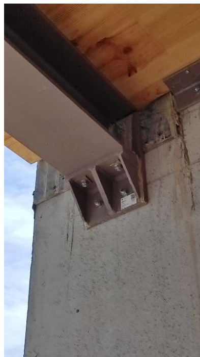
Figura 39 - Ligação aço-betão (Fonte: Autor)
