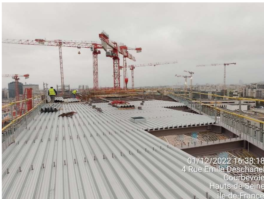
Figura 45 Chapa colaborante 2 (Fonte: Autor)
