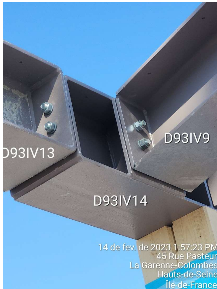
Figura 36 - Ligação aço-aço (Fonte: Autor)
