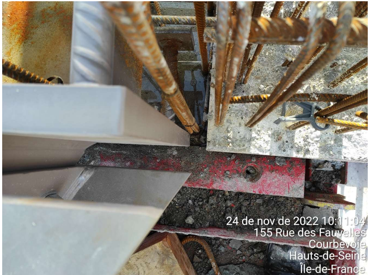
Figura 33 - Verificação da face do chumbador em relação a face do betão (Fonte: Autor)
