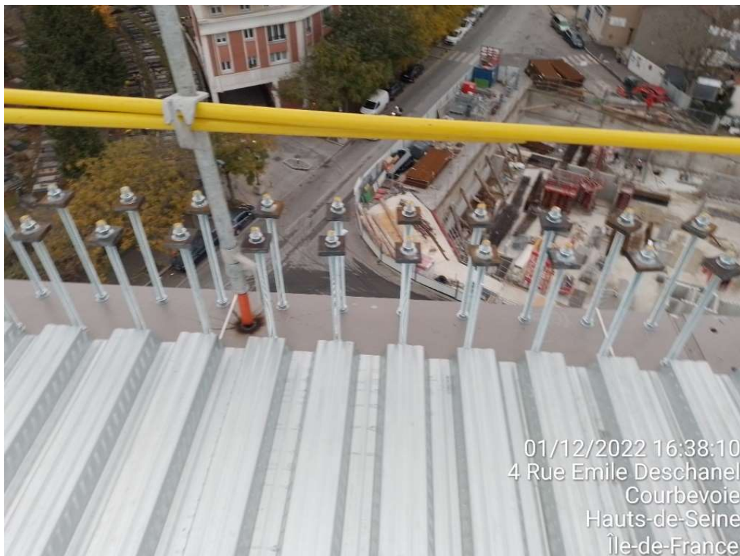
Figura 41 - Suporte de GC soldado em obra (Fonte: Autor)
