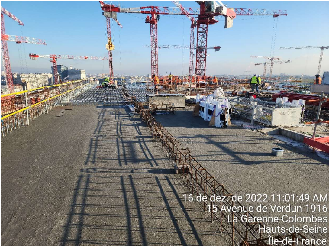
Figura 50 - Laje betonada (Fonte: Autor)
