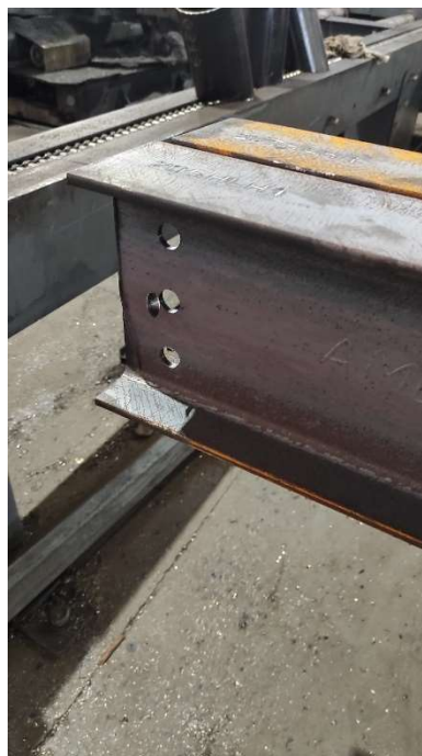
Figura 22 - Furação de perfil (Fonte: Autor)
