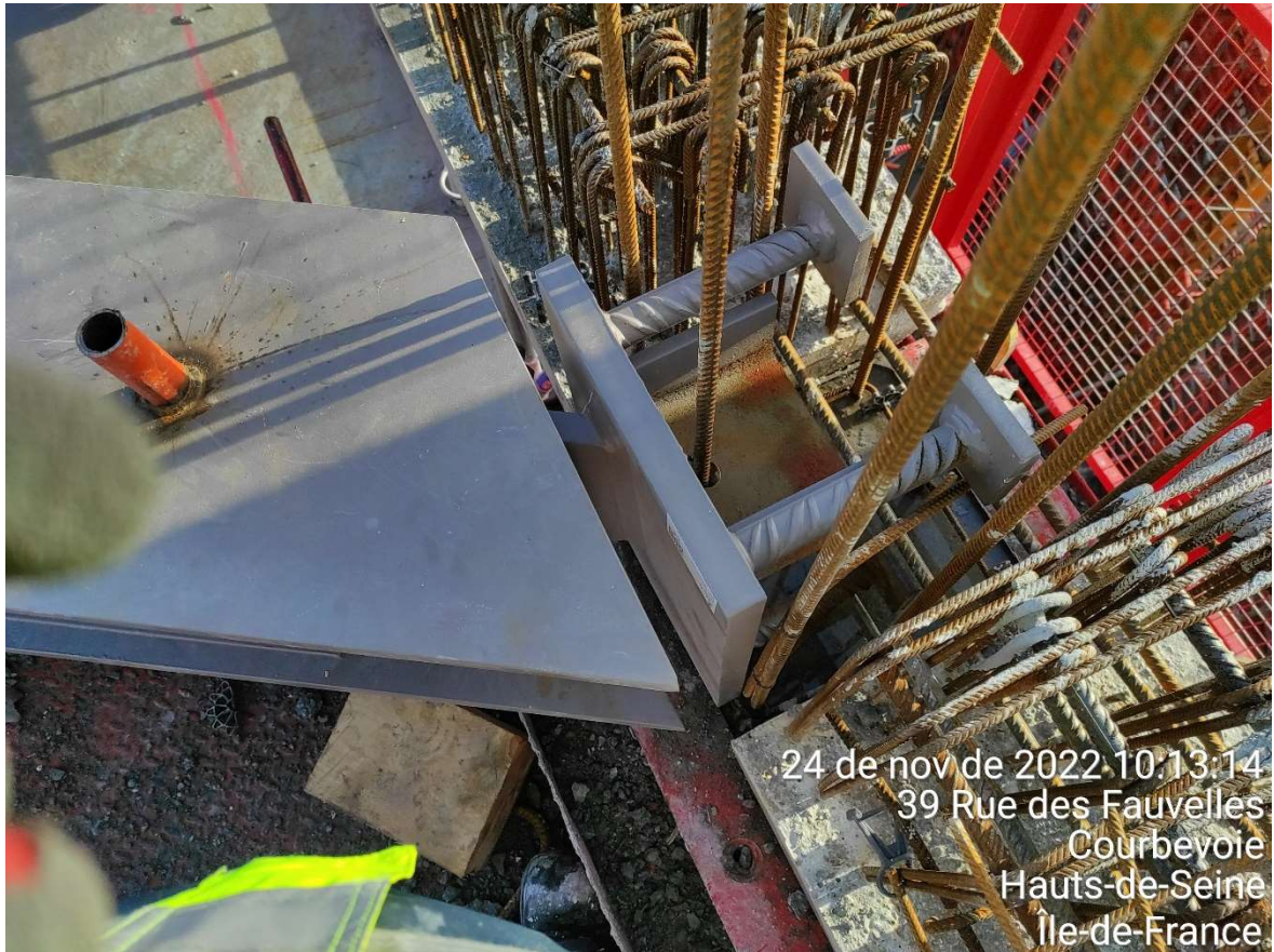
Figura 32- Chumbador em posição (Fonte: Autor)
