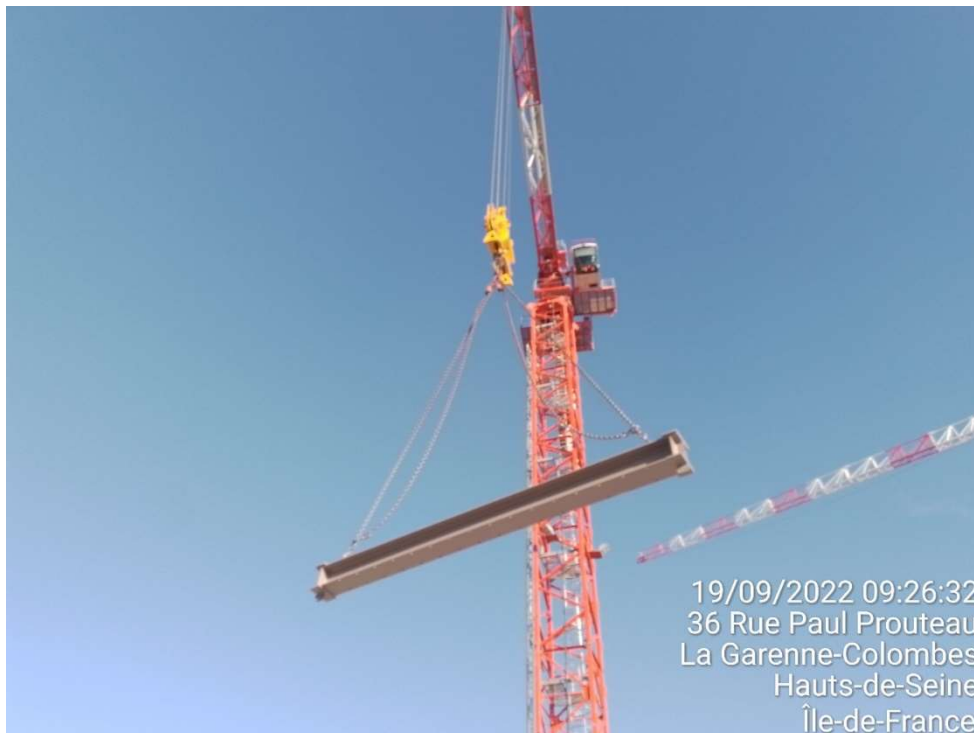
Figura 31 - Viga sendo levada pela grua (Fonte: Autor)
