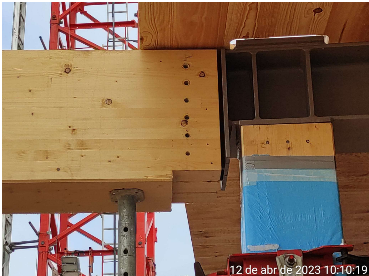
Figura 35 - Furos pré feitos nas vigas de madeira (Fonte: Autor)
