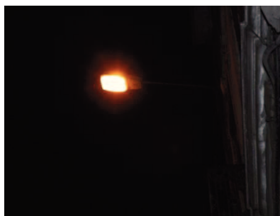
Figura 31 - Luminária suspensa no prédio
