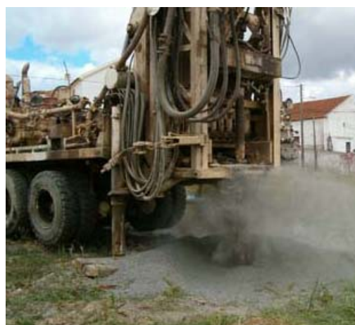
Figura 3.11 - Perfuração a ar comprimido
