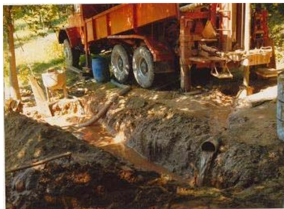
Figura 3.14 – Perfuração a “rotary”
