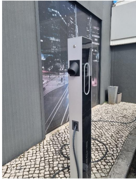
Figura 10 - Torre de carregamento
