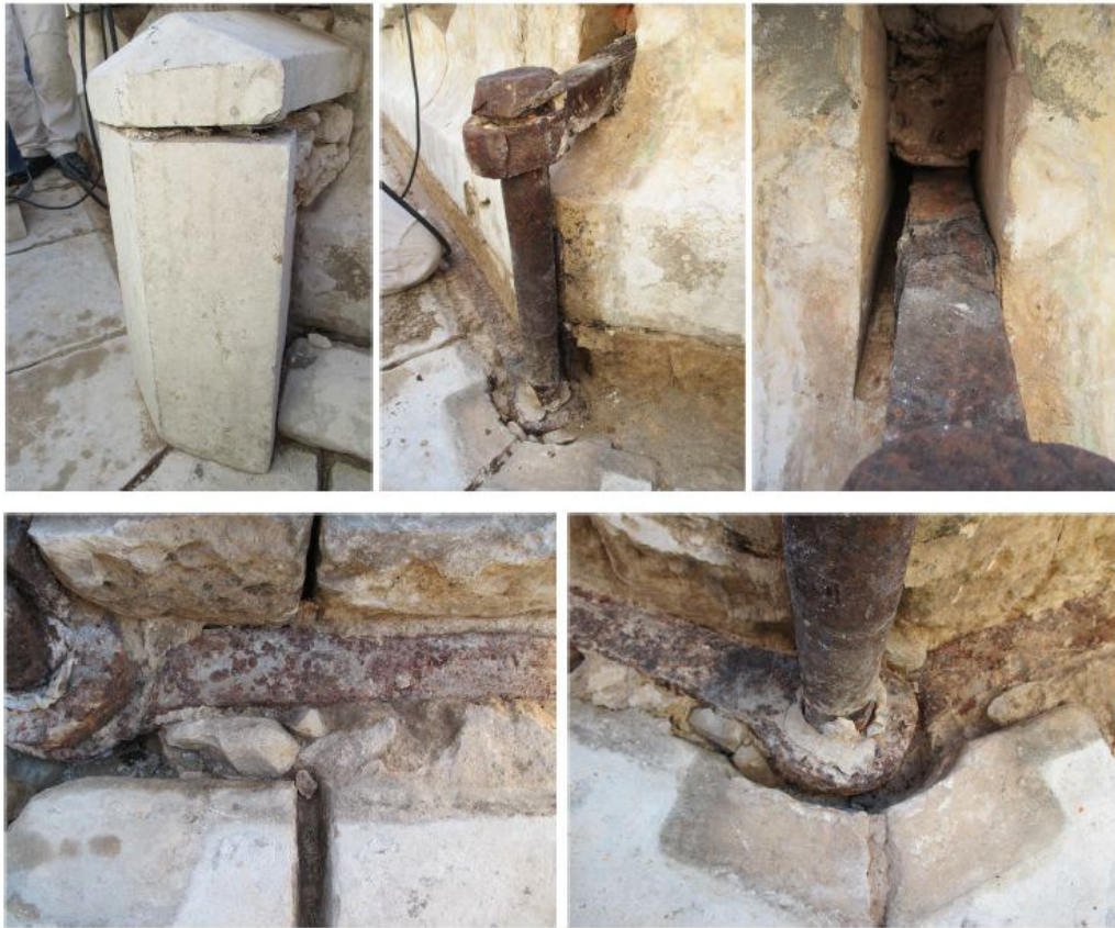
Figura 21 - Elementos metálicos consolidantes da cobertura da CF (AOF - Augusto de Oliveira Ferreira & Co, Lda, 2014)
