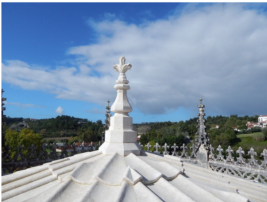
Figura 13 - Pedra recentemente limpa
