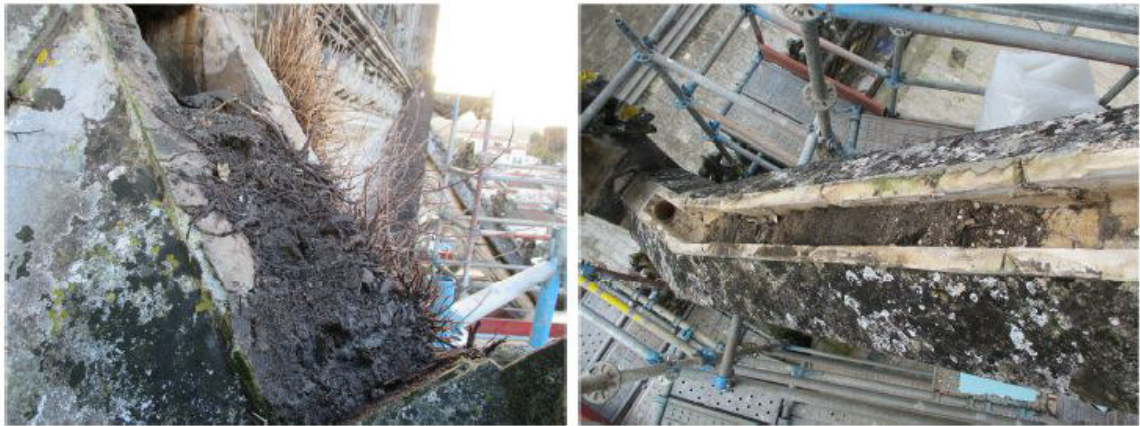
Figura 5 - Manutenção das calhas interiores dos arcobotantes (AOF - Augusto de Oliveira Ferreira & Co, Lda, 2014)
