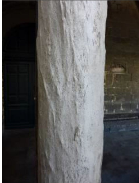
Figura 29 - Desintegração granular em coluna de mármore (Bromblet, et al., 2012)
