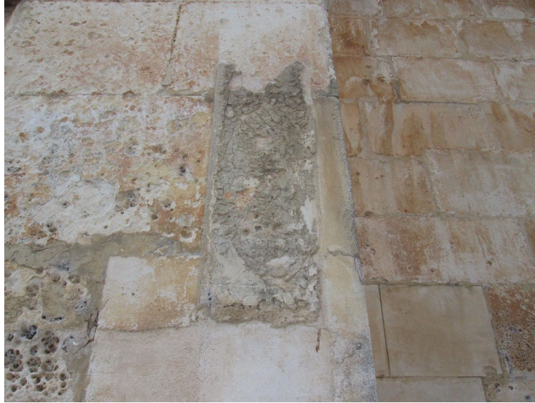
Figura 24 - Argamassa aderente à pedra
