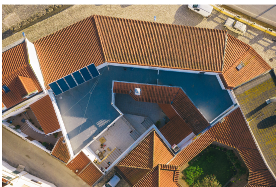
Figura 6. Vista aérea do edifício
