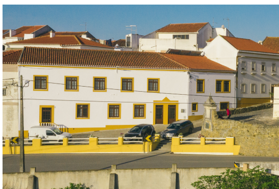
Figura 5. Fachada do edifício
