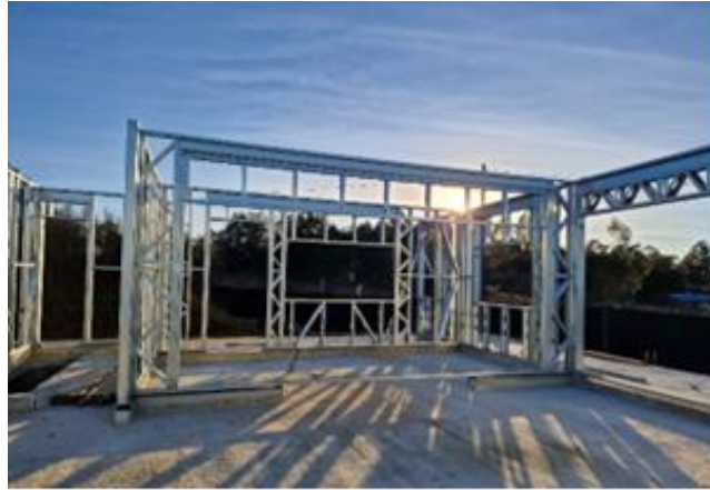
Figura 1 - Construção em Light Steel Framing
